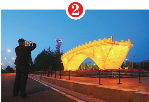
▲北京奥林匹克公园园区内安装大型景观建筑“丝路金桥”。
