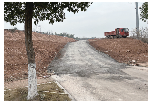
▲施工区域通往升龙大道的道路已硬化。 记者/刘平 摄
