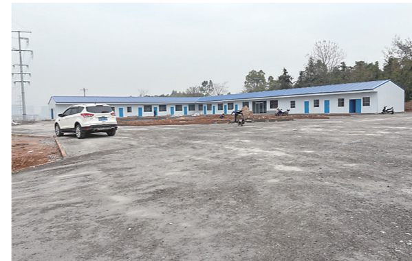
▲涉嫌非法占地的区域,已大面积硬化。 记者/刘平 摄
