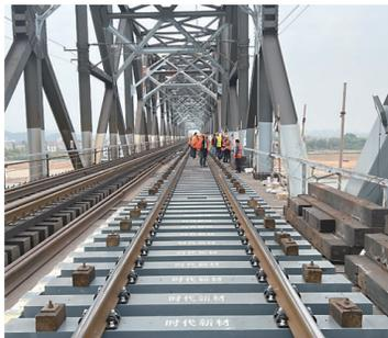
吉安赣江大桥装上了时代新材提供的复合材料桥枕 企业供图
