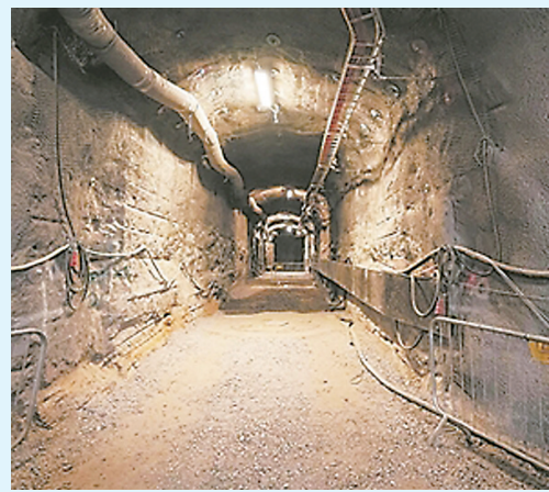
▲位于芬兰奥尔基洛托岛地下核废料储存设施内的隧道。
