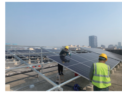
工人们正在屋顶安装太阳能光伏发电板。 记者/刘芳 摄
