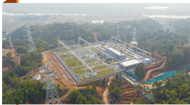
已经投运的醴陵东(荆潭)220千伏输变电工程。 通讯员/喻军 摄
