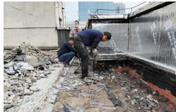
▲施工人员拆除楼顶原有防水层。记者/易楚瞳 摄
