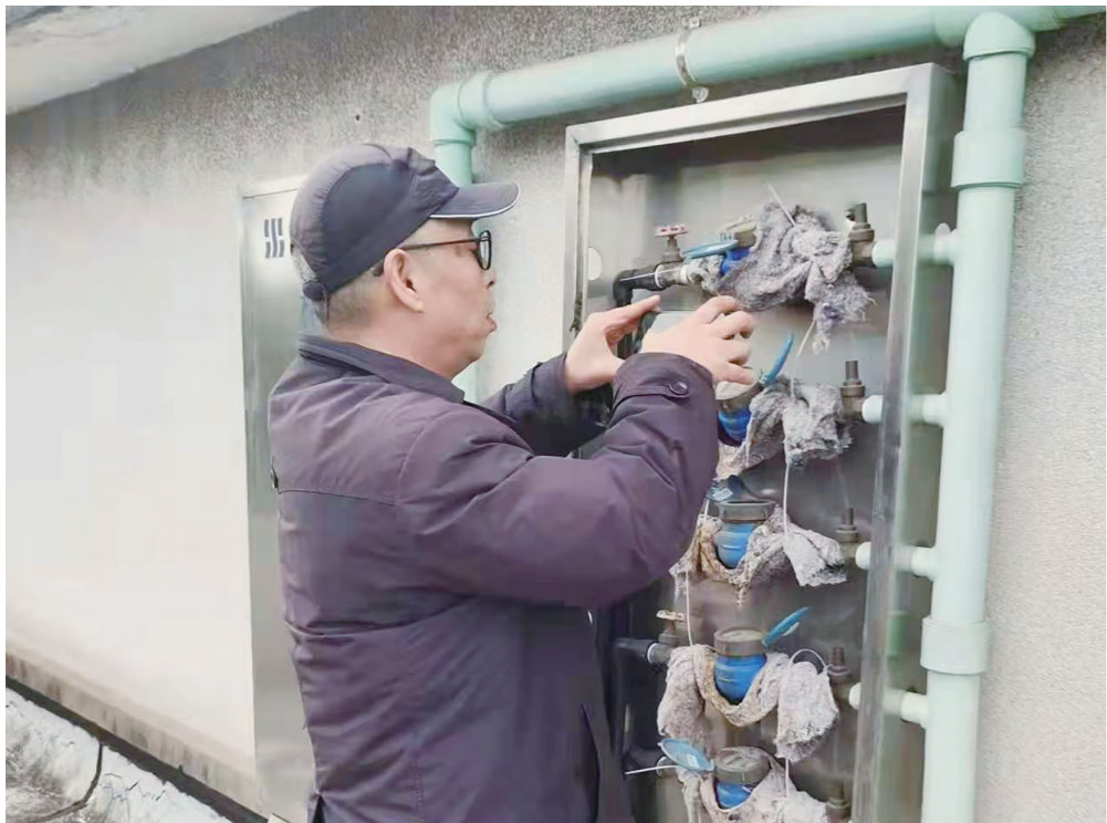
市水务集团工作人员检修供水设施 吴楚/摄
