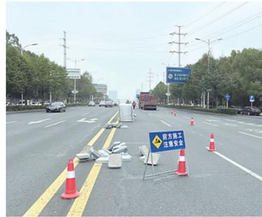
12月7日,天元区株洲大道体育中心路段,道路中间双黄线位置开始施工安装隔离护栏,以有效杜绝车辆违规调头、行人随意横穿马路等现象。施工现场,部分行车道被占用,过往车辆需要注意减速慢行。
