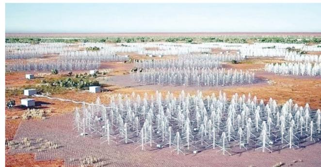
▲无线电天线站艺术图。每个站有256个天线,SKA-Low 望远镜将有512个站。(图片来源:澳大利亚《对话》网站)
