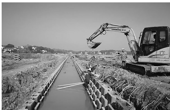
施工人员正在维修水渠 通讯员供图
