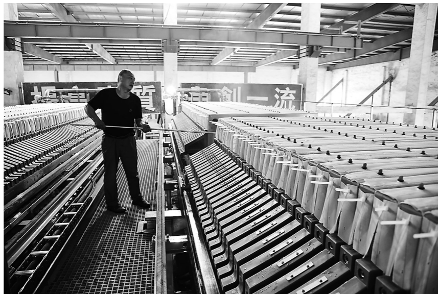
兴隆新材白炭黑二车间压滤工序智能化生产线。资料图
