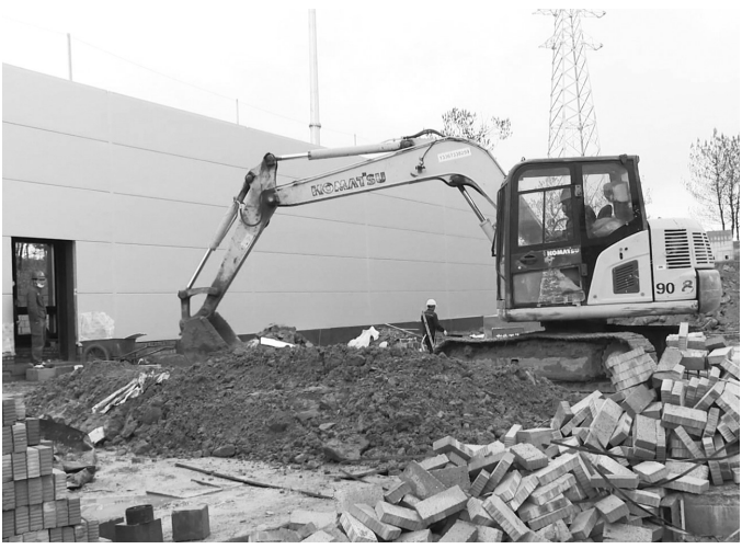
舂舂输电工程施工现场。谭斌斌 供图
