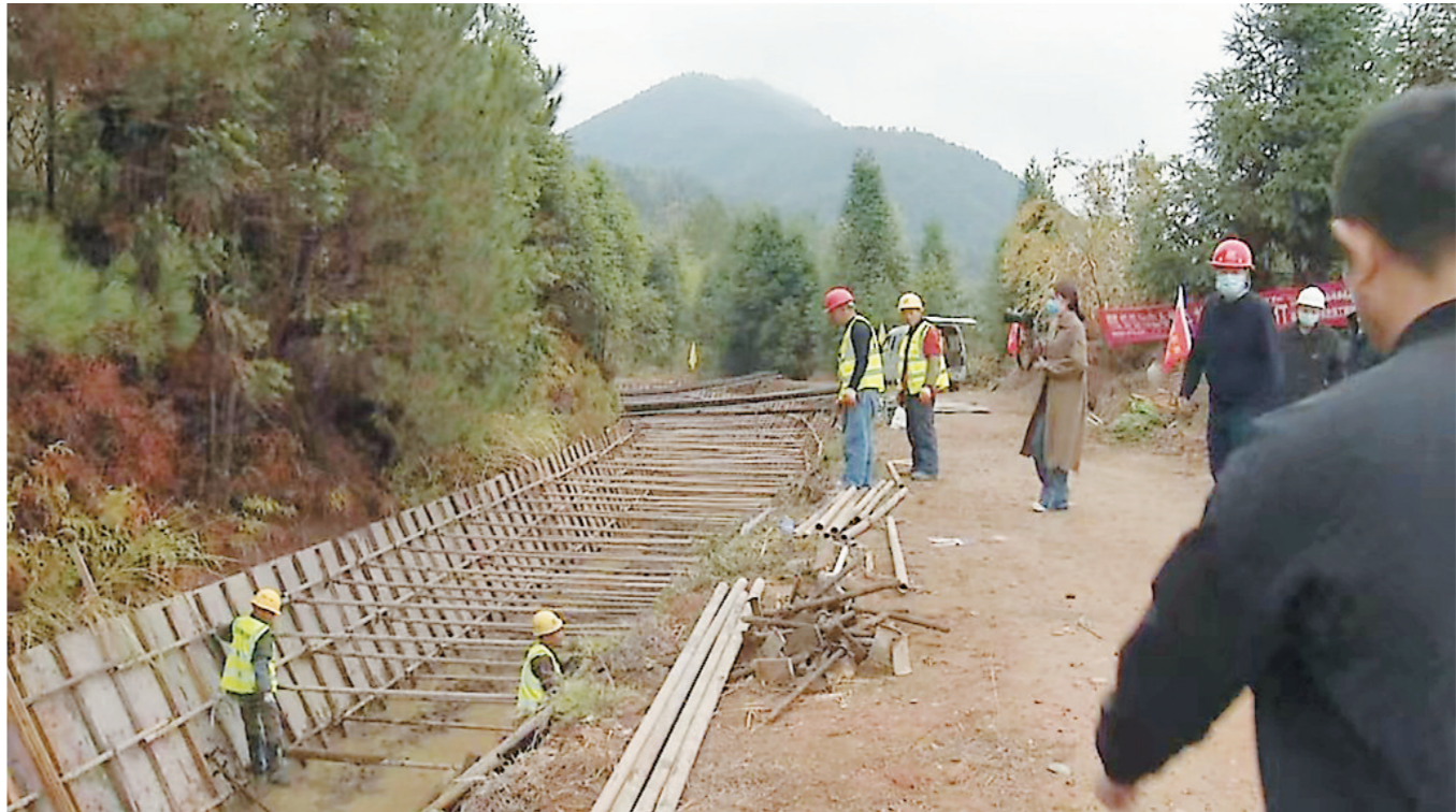
河东灌区续建配套与节水改造工程施工现场。通讯员供图
