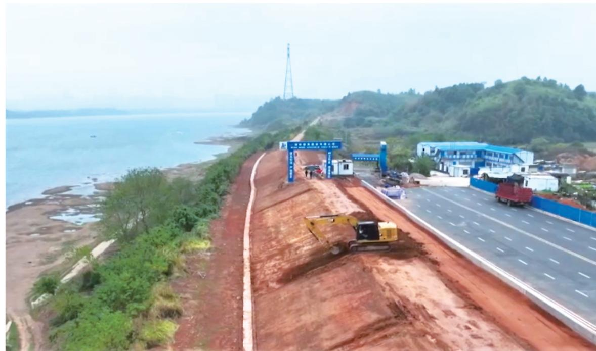
▲入冬以来,溁口区抢抓持续天晴、河流水位较低的水利建设黄金时期,掀起冬修水利热潮。图为11月22日上午,该区溁口镇青龙湾湘江流域一处施工点,一台挖机正在进行整坡加固作业。
