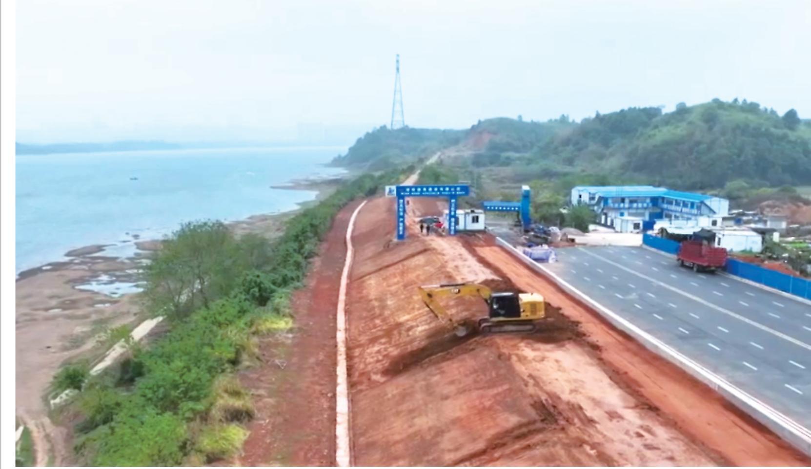
▲入冬以来，渌口区抢抓持续晴朗、河流水位较低的水利建设黄金时期，掀起冬修水利热潮。图为11月22日上午，该区渌口镇青龙湾湘江流域一处施工点，一台挖掘机正在进行整坡加固作业。
