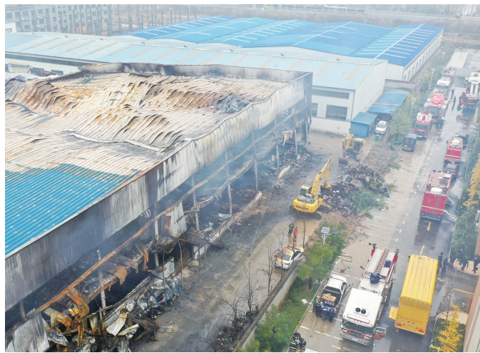
▲11月22日,消防救援人员在河南安阳火灾现场(无人机拍摄)。据新华社
