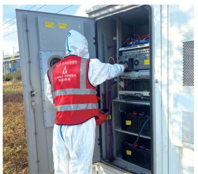
▲株洲铁塔维护人员正在石峰区时代大道白马垅处理开关电源故障。通讯员供图
