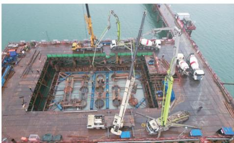
11月18日下午,在醴娄高速湘江特大桥施工现场,随着最后一车混凝土浇筑到位,历经24小时的湘江特大桥12#主墩承台封底顺利浇筑完成。
