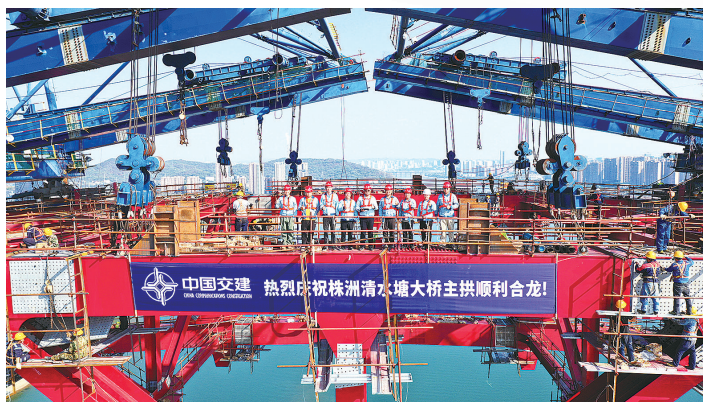
株洲清水塘大桥主拱顺利合龙。
