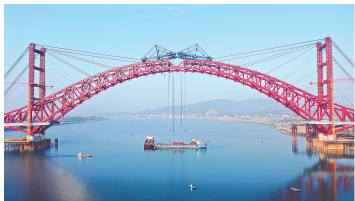
主拱合龙吊装过程。
