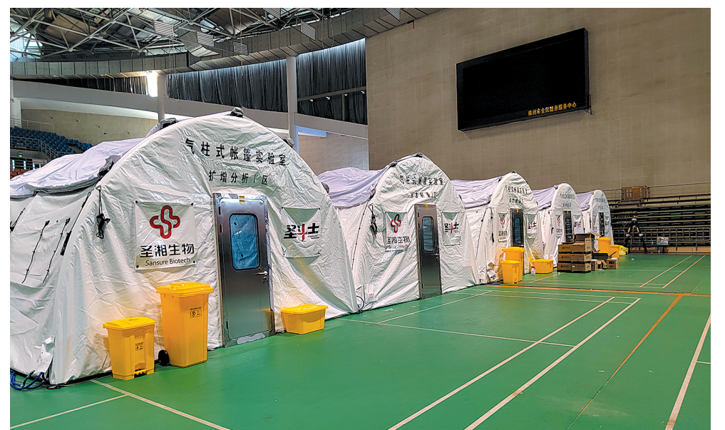
气膜核酸检测基地中的气柱式帐篷实验室。株洲日报全媒体记者/易楚瞳 摄
