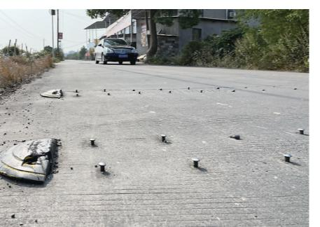
十余条减速带破损,在路面留下一排排“钢钉”……10月31日,有车主途经芦淞区五百路发现,道路上多处减速带受损严重,影响车辆及行人通行。
