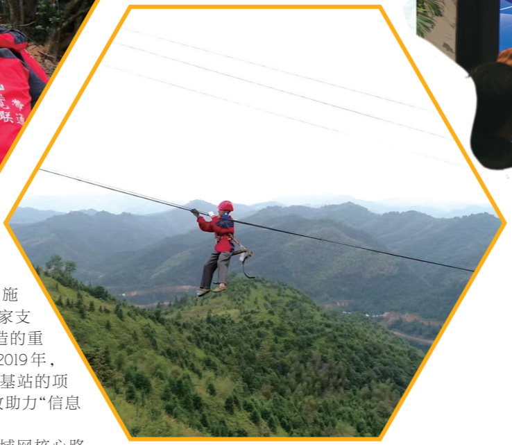
▲高空架设通信线路。
