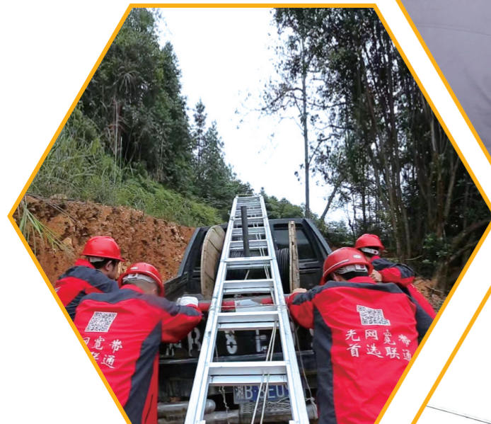
▲架设通信线路。
