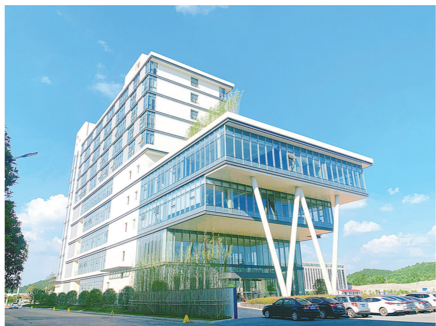
中天杭萧科研楼是全省首个采用钢管混凝土束组合结构的绿色建筑。株洲日报全媒体记者/吴楚 摄
