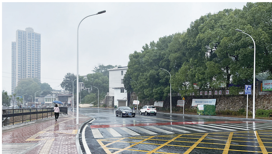
▲改扩建后的先锋路,新路灯未投入使用。记者刘平摄
