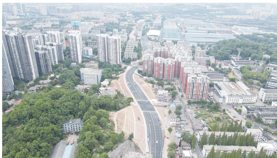
改造完成通车的田心路。记者/吴楚 摄
