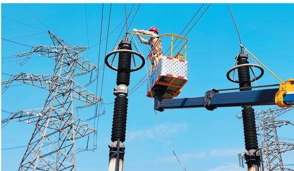
近日,国网株洲供电公司圆满完成白坭变电站C类检修任务,这是该公司首个开展的220千伏变电站综合检修任务,主要是对站内部分老旧设备进行升级改造,包括站内220千伏母线606断路器、电流互感器等一次设备的例
