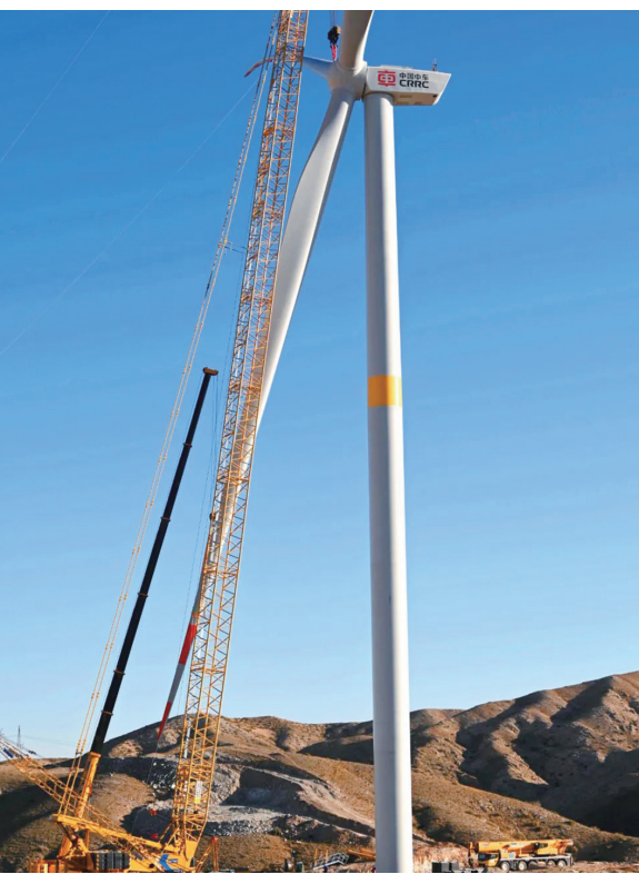
中车株洲所首台6.25MW陆上风力发电机组成功吊装。企业供图
