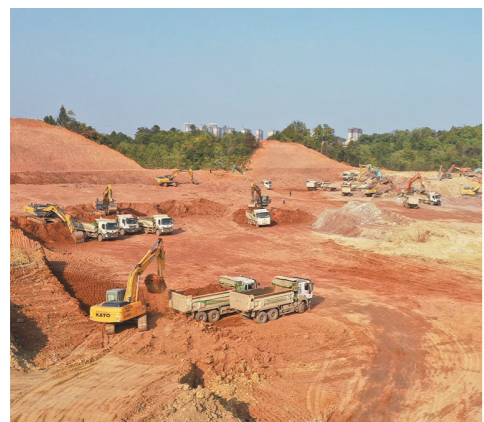
项目施工现场。 记者/杨凌波 摄
