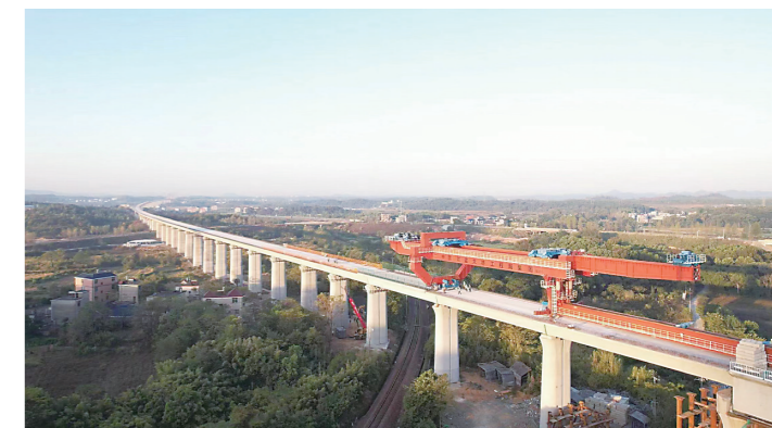
▲10月14日,昌景黄铁路3标425福箱梁架设全面完成。 受访单位供图
