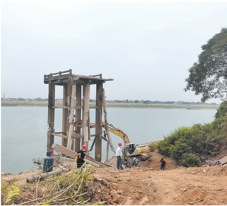
淦田镇华石煤矿卸煤码头整治现场。株洲日报全媒体记者/俞强年 通讯员/叶叶湖 摄
