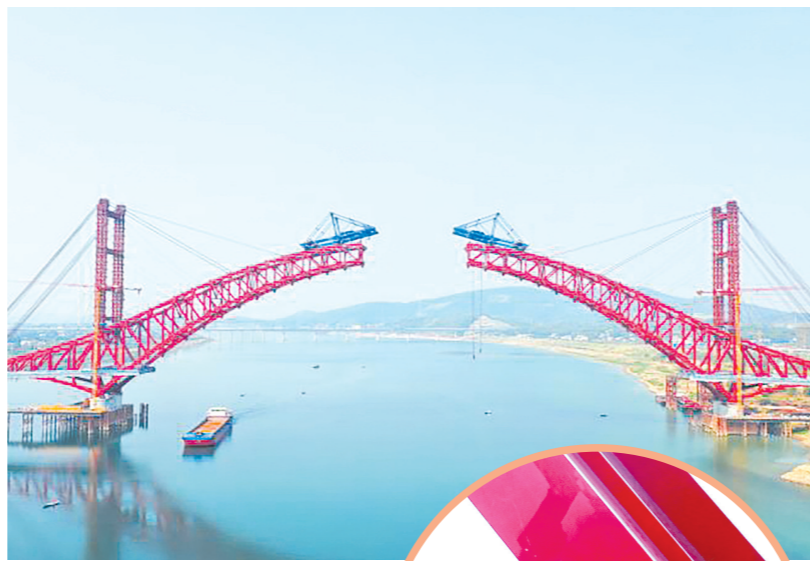
▲正在建设的清水塘大桥
