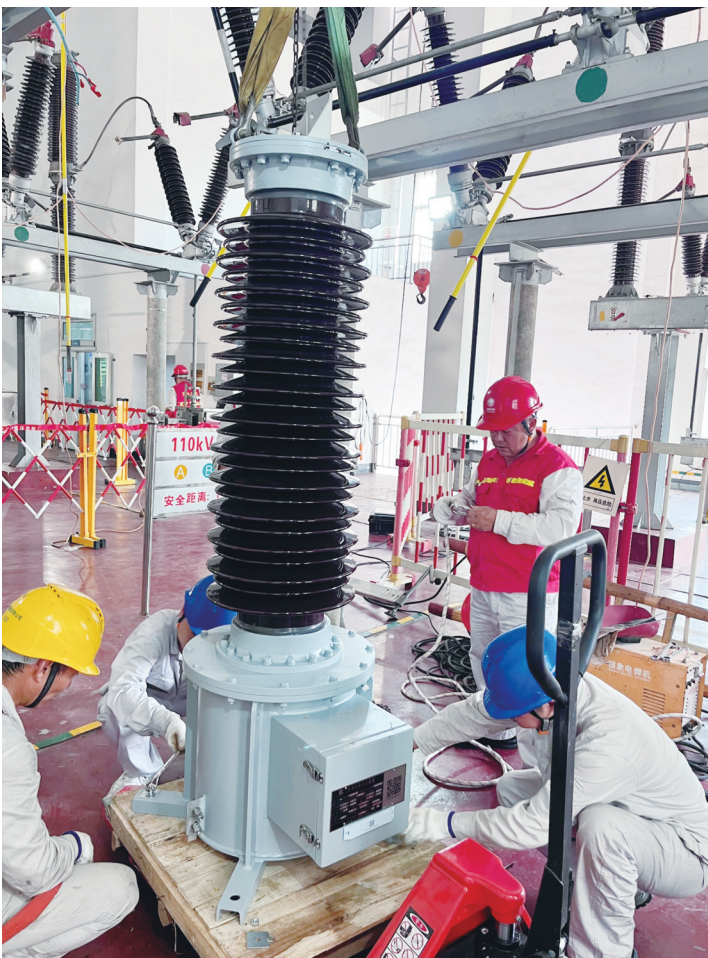
工作人员正在更换电压互感器。受访企业 供图
