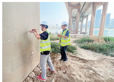
▲专业人员对天元大桥开展结构检测。通讯员供图
