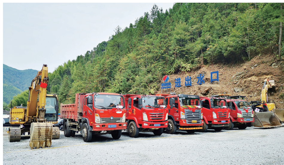
▲炎陵抽水蓄能电站项目开工现场。记者/廖喜张 摄
