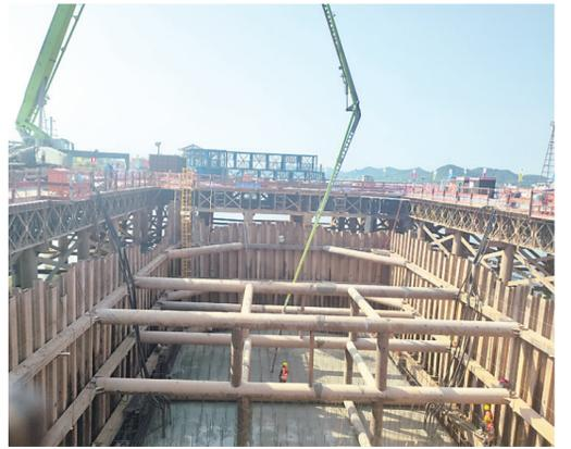
9月19日,经过两天天泵布料、两个小时的连续奋战,醴娄高速第四合同段顺利完成了株洲湘江特大桥主墩承台浇筑,标志着主桥桥梁水中基础施工取得了重大突破,为后续施工积累了宝贵经验。
