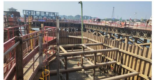
9月19日,经过两台天泵布料两个小时的连续奋战,醴娄高速第四合同段顺利完成了株洲湘江特大桥主墩承台浇筑,标志着主桥桥梁水中基础施工取得重大突破,为后续施工积累了宝贵经验。此次浇筑的首座承台为主桥11#墩承台,承台采用六边形,用C40混凝土分两层浇筑。主墩承台采用钢平台+钢板桩围堰的施工工艺,围堰内基坑最大开挖深度超过12m,共计浇筑混凝土1230m³。
