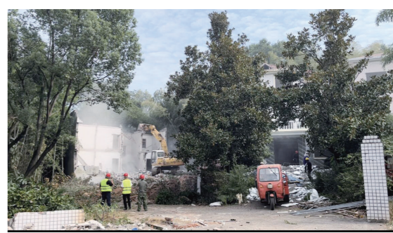
执法人员依法拆除违建房屋。记者/周高 摄
