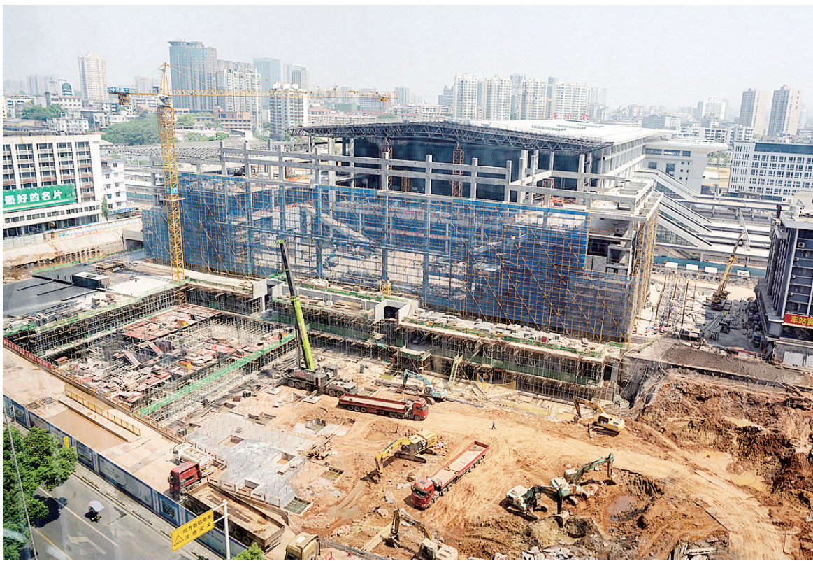
9月17日,烈日炎炎,在株洲火车站西站房建设现场,工程机械轰鸣声不断,工人们正在有条不紊地紧张施工。目前,西站房完成了钢筋混凝土结构施工,预计9月底完成屋面钢结构施工,11月底完成外立面幕墙施工;高架候车厅完成了混凝土和钢结构施工,西广场正在进行土方开挖和主体结构建设。预计年底具备开通条件。
