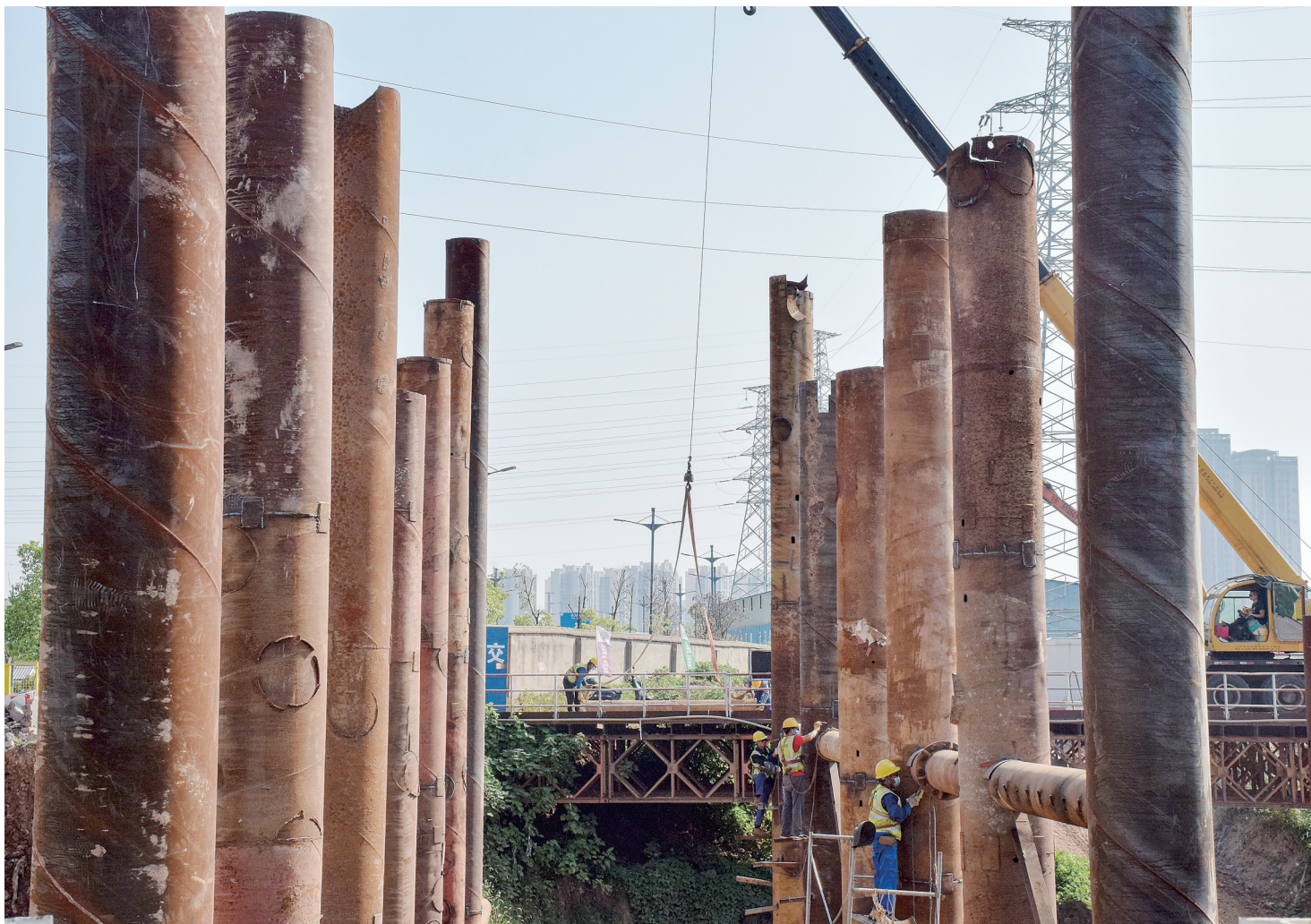
▲9月11日,正值中秋小长假,在中交二航局株洲市铁东路项目跨白石港主线桥梁施工现场,一线工人正在进行焊接作业。
