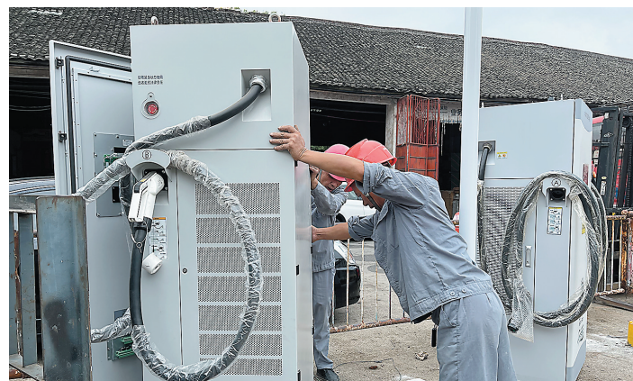
株洲市电动汽车公司的技术人员在茶陵县汽车中心站安装快充充电桩。 通讯员/陈翥 摄
