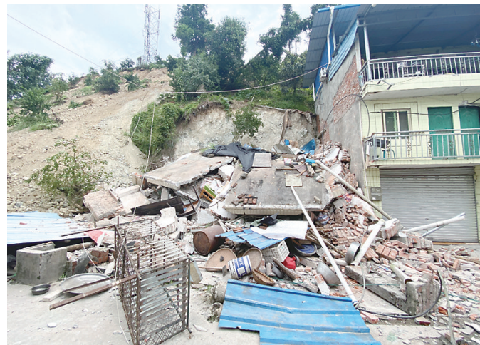
▲这是石棉县王岗坪乡挖角村房屋受损情况(9月6日摄)。 据新华社
