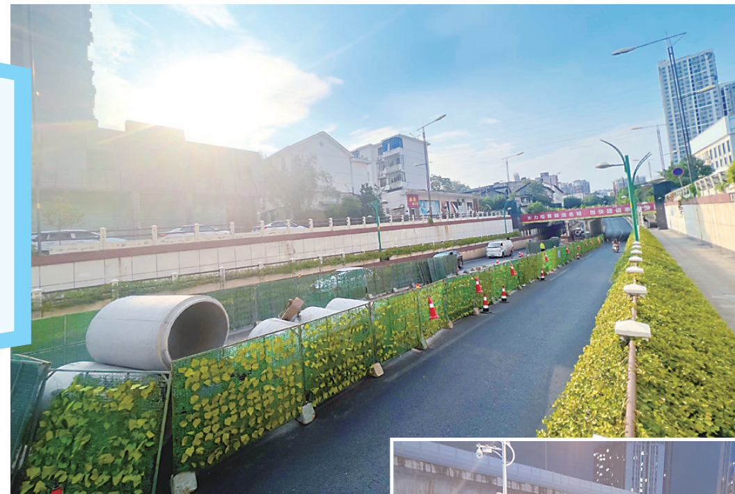
►石峰区电厂立交桥排水改造工程现场。伍靖雯/摄
