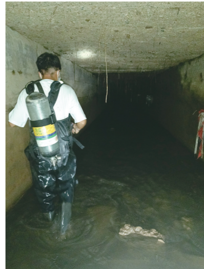
工人带着氧气瓶进入箱涵溯源摸排
