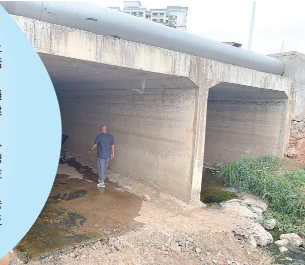
田心片区横石干渠生活污水截污工程已告一段落
