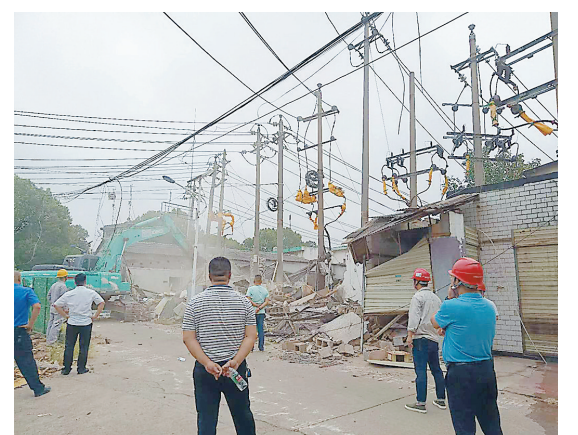
图为拆违现场。株洲日报通讯员/刘兵 供图
