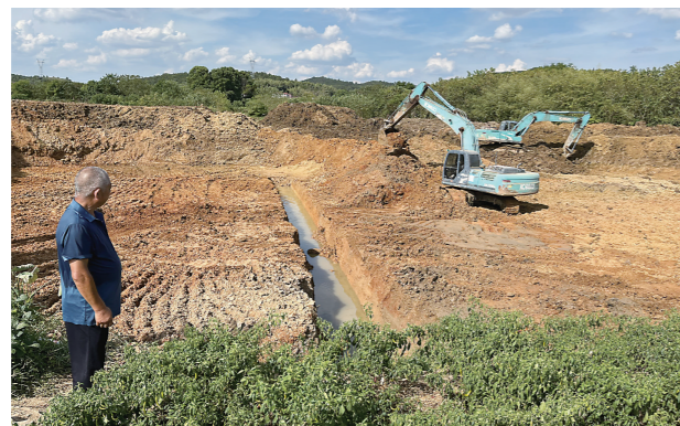
▲8月27日,两辆挖掘机在挖蓄水塘。记者刘平摄
