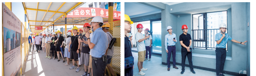
▲8月27日,众多媒体及业主共同参观株洲建发央著二期工地。
