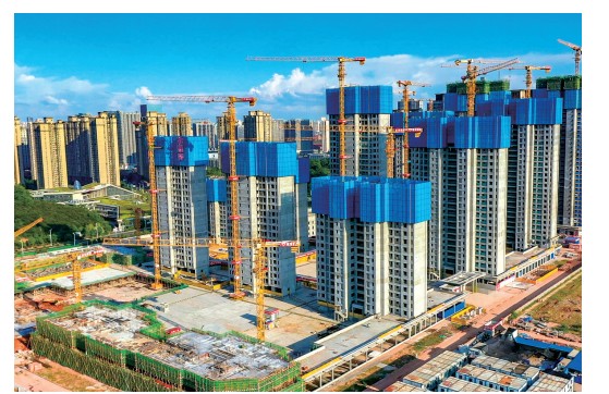
▲株洲建发央著二期工地实景图。
