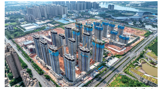
▲株洲建发央著一期工地实景图。
