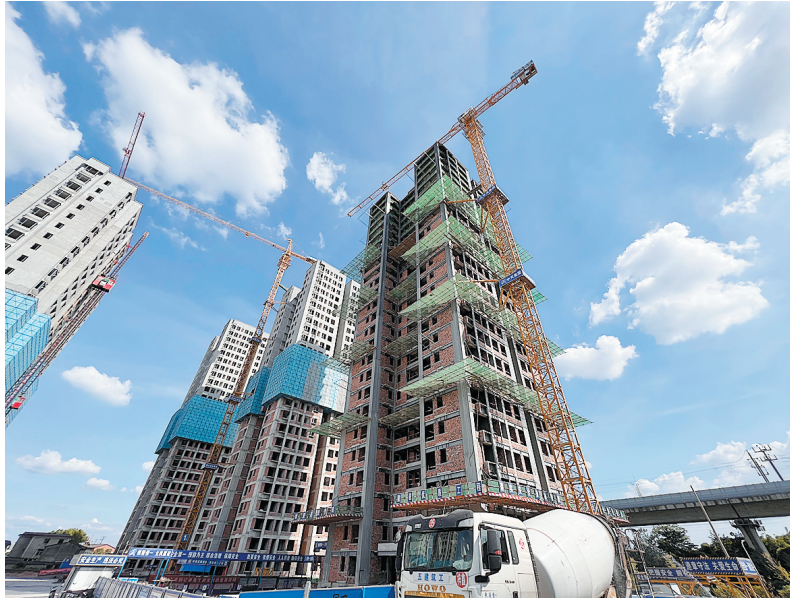
株洲首栋钢结构装配式廉租房提前封顶。株洲日报全媒体记者/吴楚 摄
