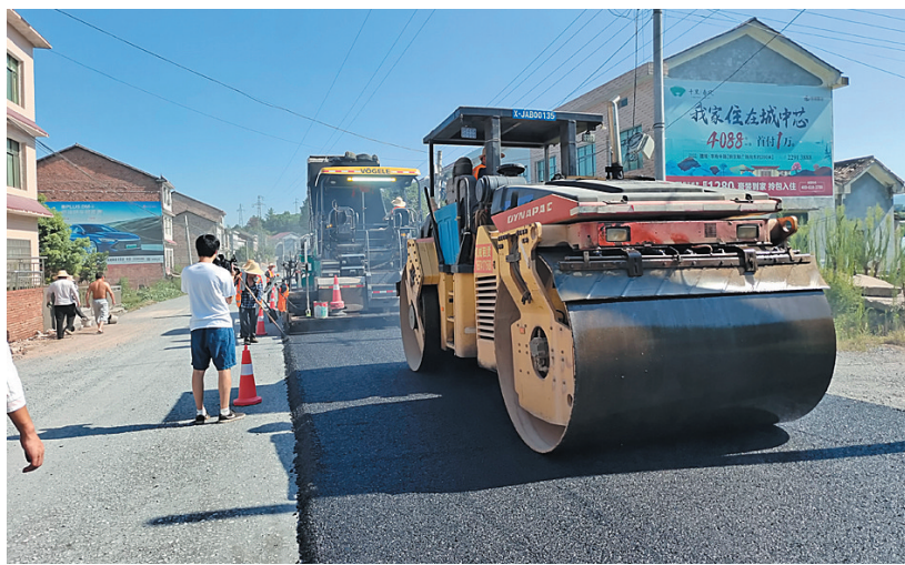
S204醴官线七里山村路段改造施工现场。株洲日报全媒体记者廖明 摄
