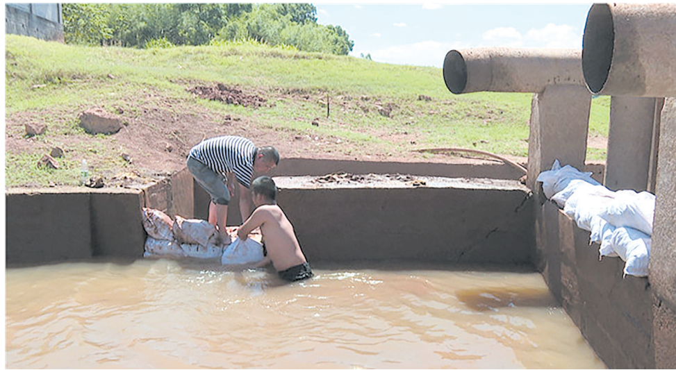
抢修现场。通讯员 供图
