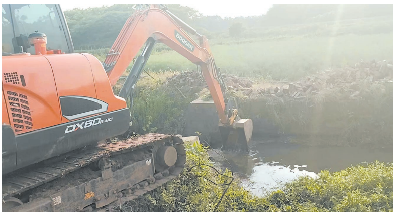
龙升社区渠道清淤。通讯员/杨霞 摄
